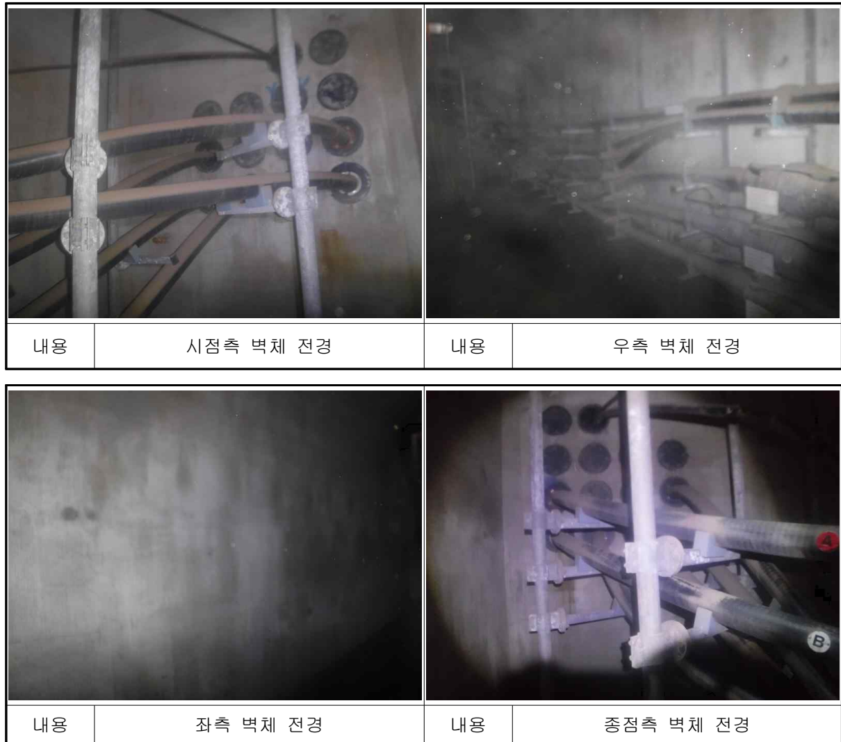
[사진 4.45] 남면~백석#10 전경
