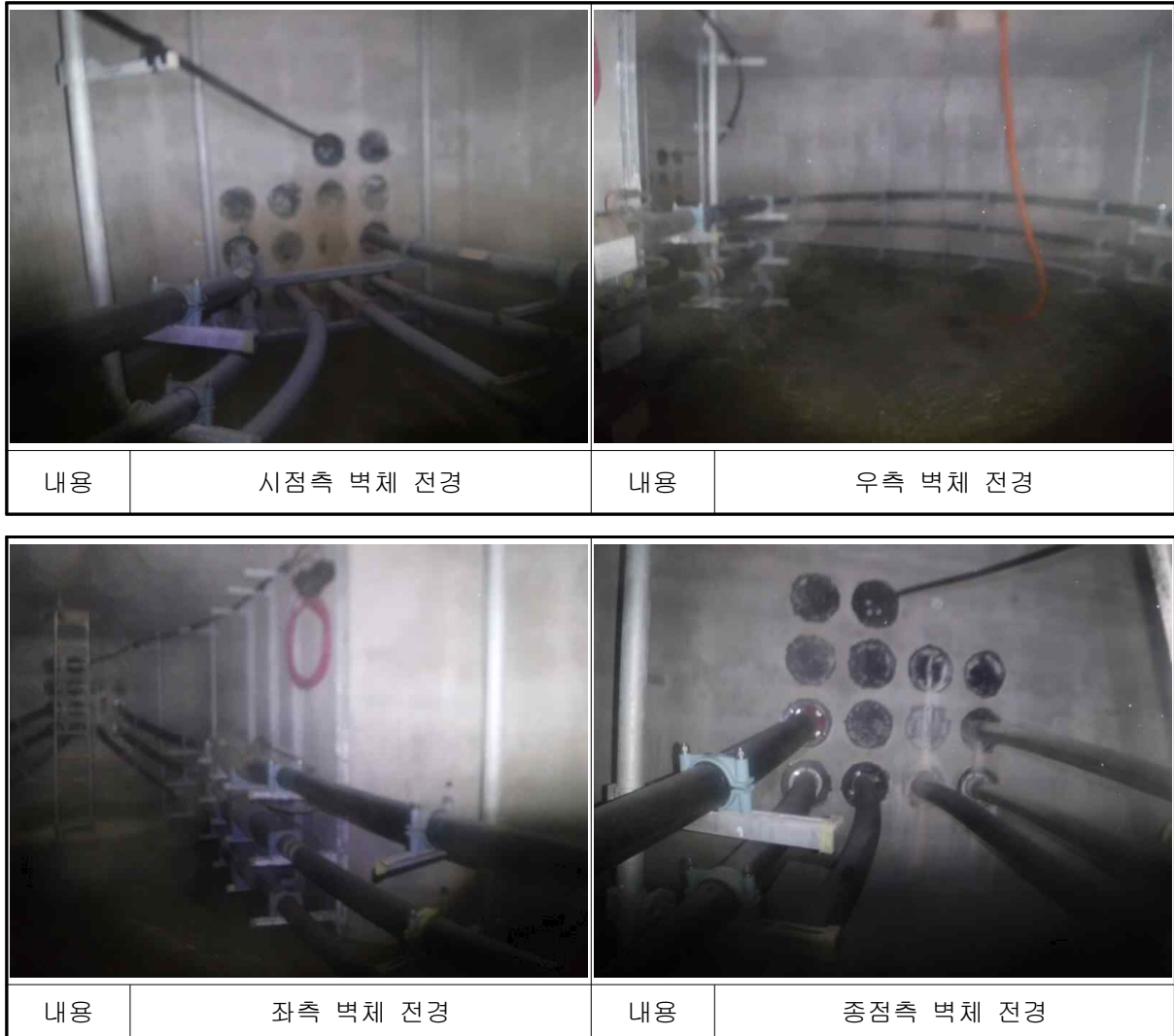
[사진 4.21] 남면~백석#4 전경
