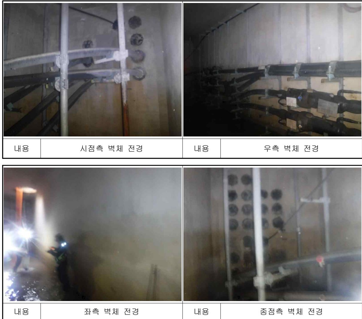
[사진 4.57] 남면~백석#13 전경
