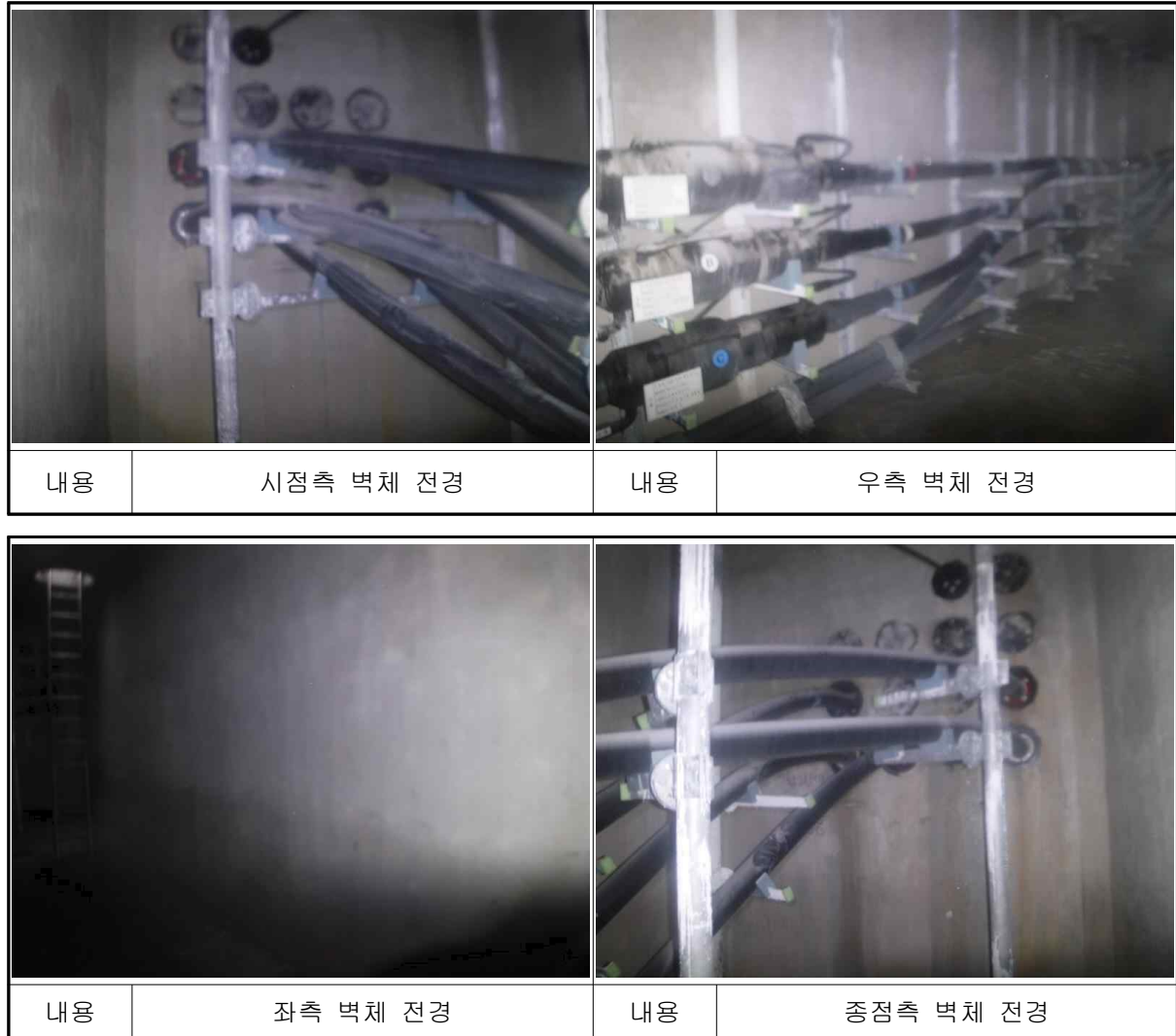
[사진 4.53] 남면~백석#12 전경
