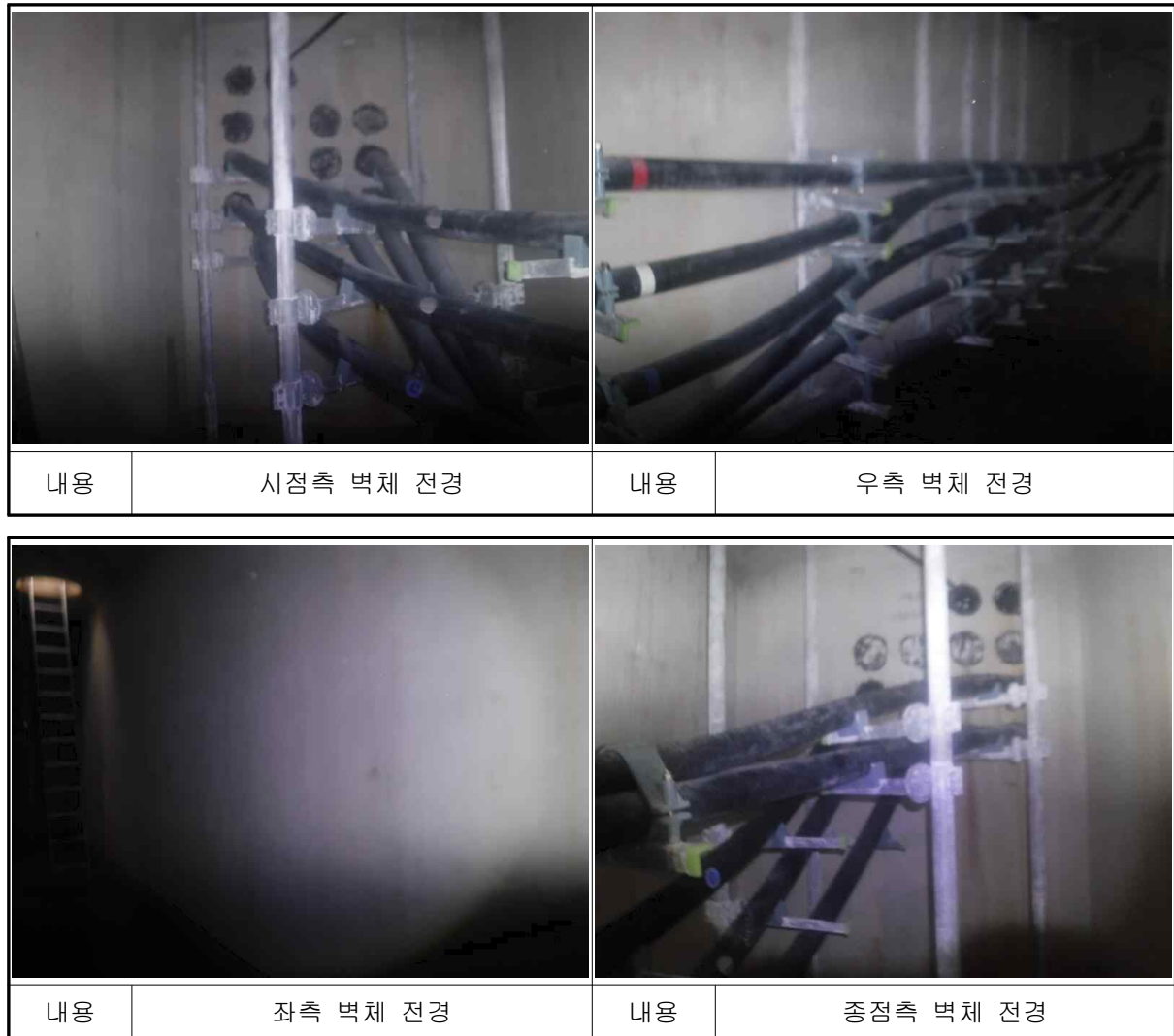
[사진 4.65] 남면~백석#15 전경
