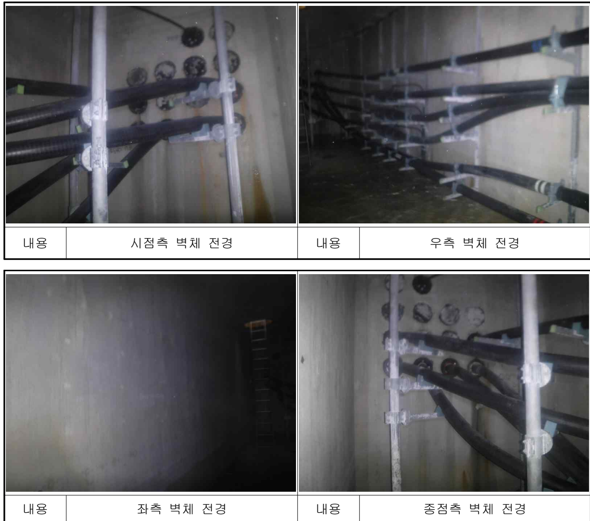
[사진 4.61] 남면~백석#14 전경
