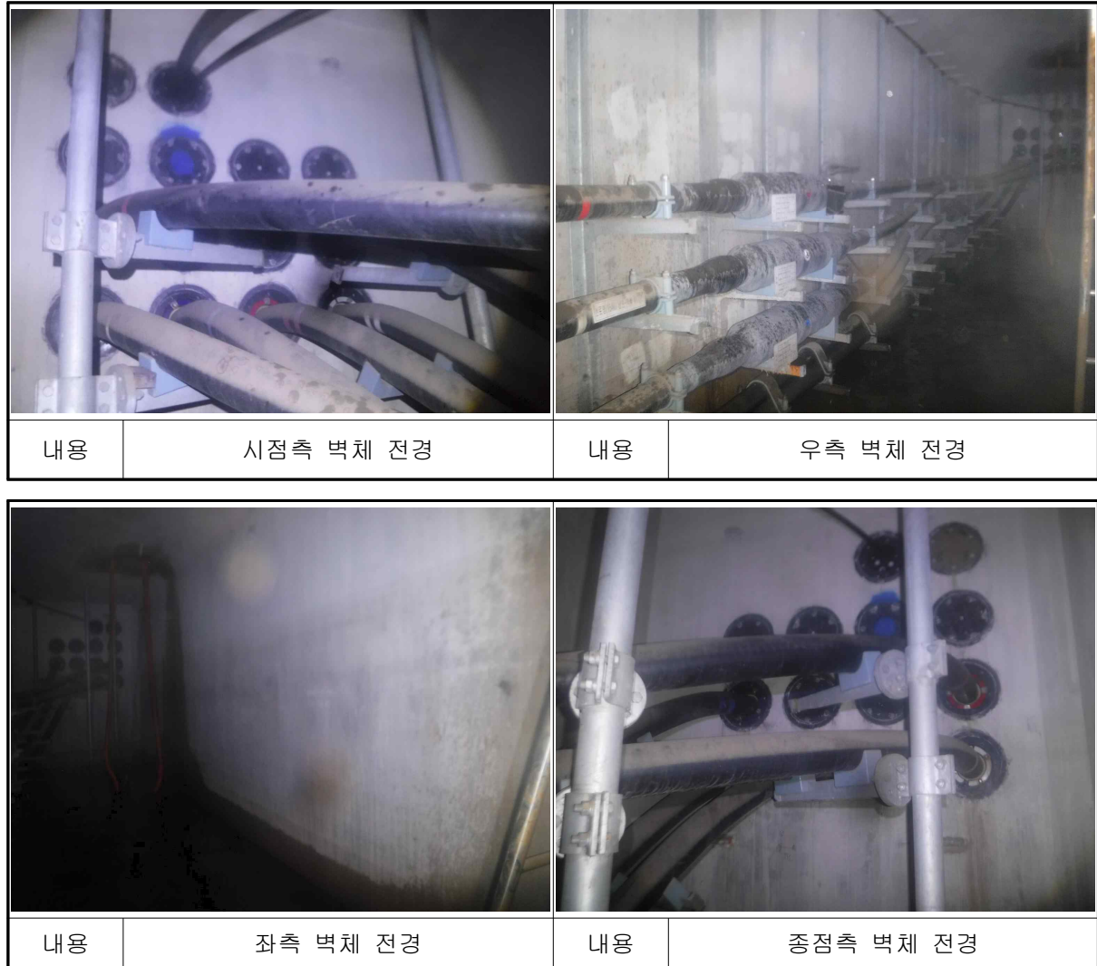
[사진 4.41] 남면~백석#9 전경
