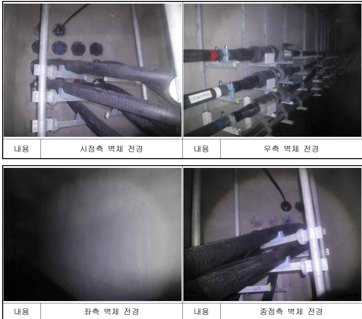
[사진 4.17] 남면~백석#3 전경
