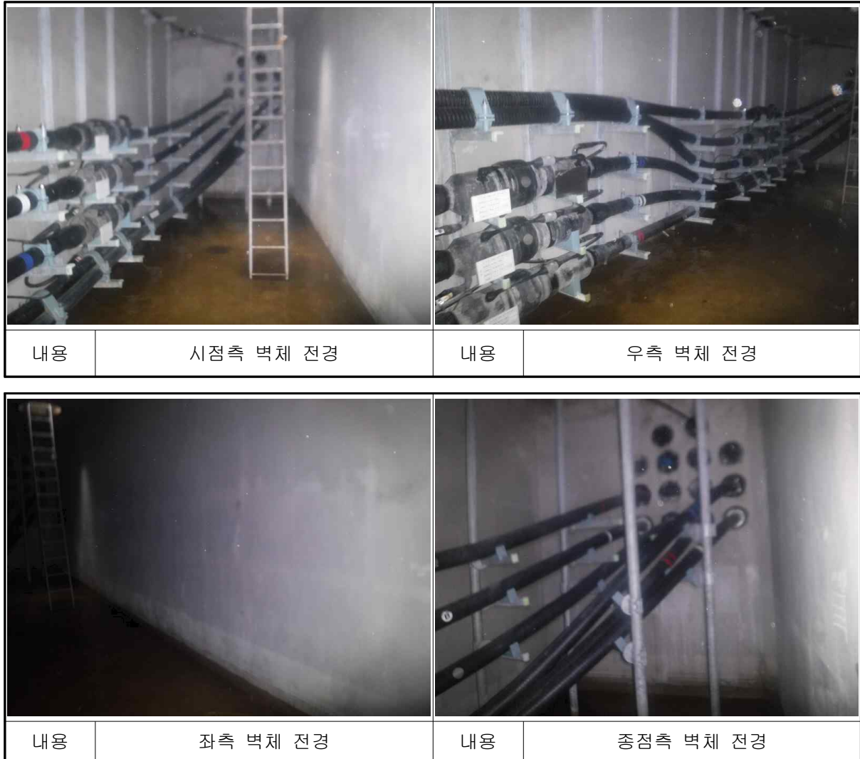
[사진 4.9] 남면~백석#1 전경
