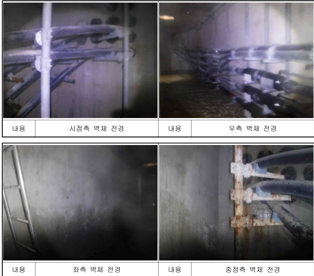
[사진 4.49] 남면~백석#11 전경
