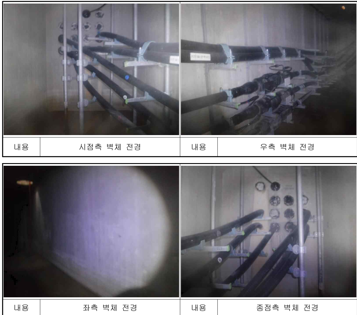
[사진 4.69] 남면~백석#16 전경
